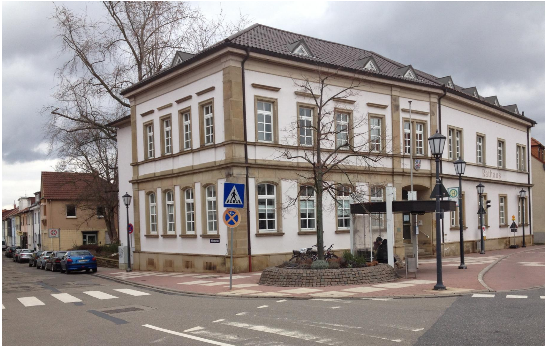
Vorderansicht_ Kreuzung Wilhelmstraße - Schwetzingen Straße
