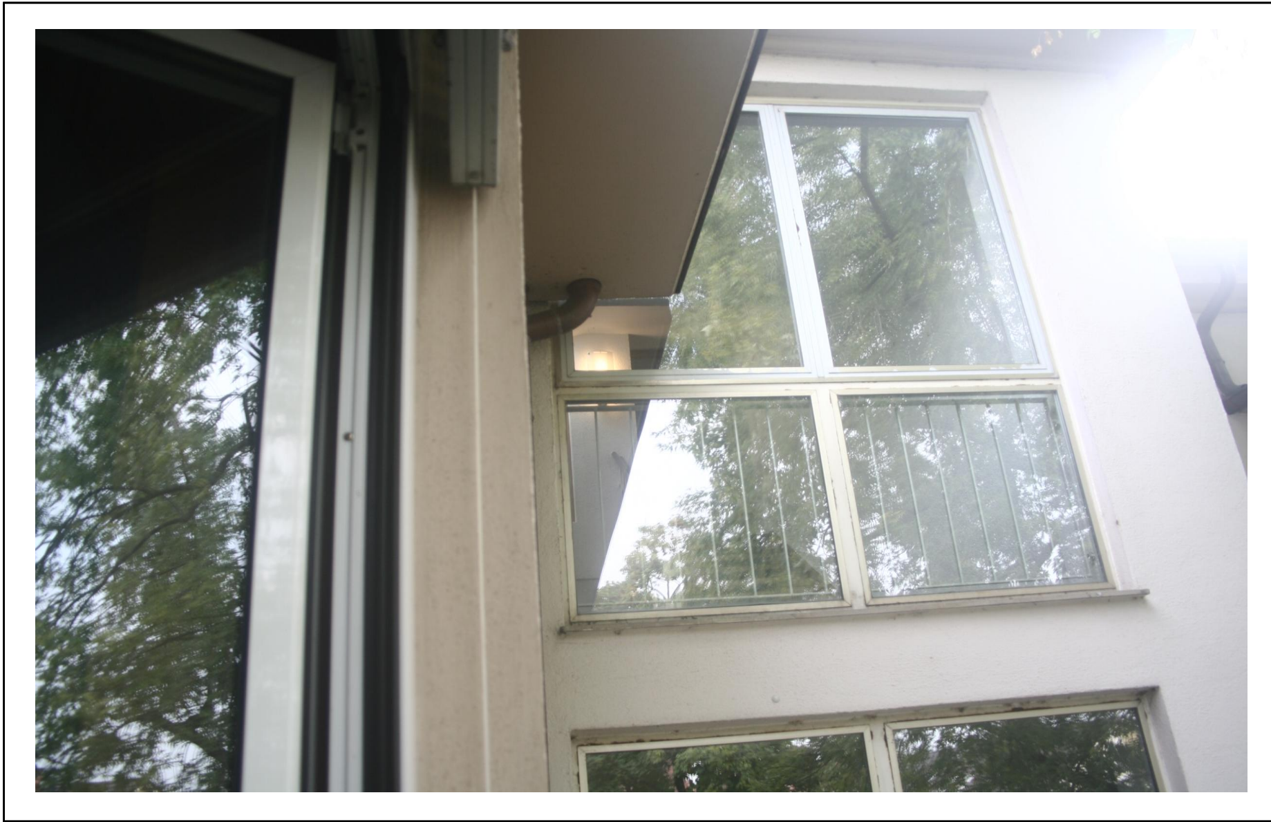
Dach_ Fenster Anbau
